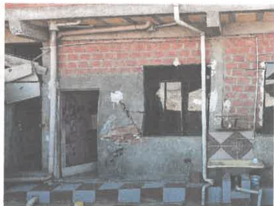
Fotografía 19. Grietas en apertura de puertas y ventanas.
