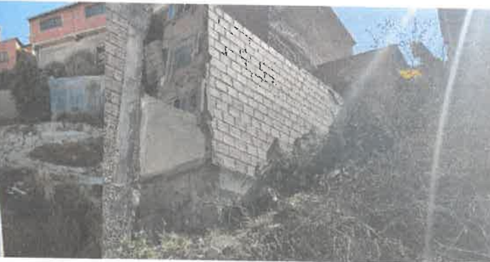
Fotografía 4. Primer Bloque del predio.
