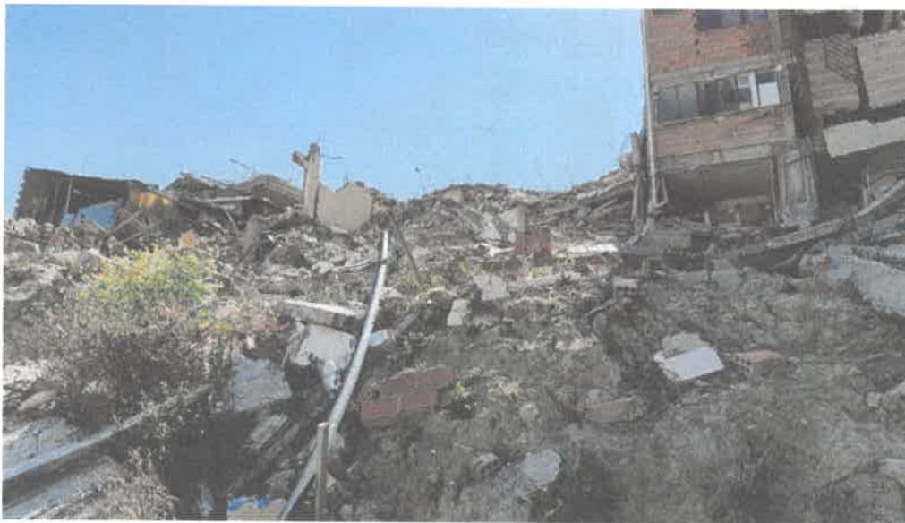
Fotografía 7. Demolición de los elementos estructurales y no estructurales casi en su totalidad.
