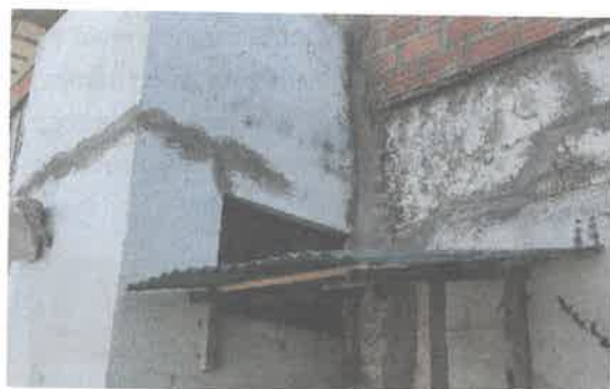
Fotografía 14. Sellado de grietas por parte de la propietaria.
