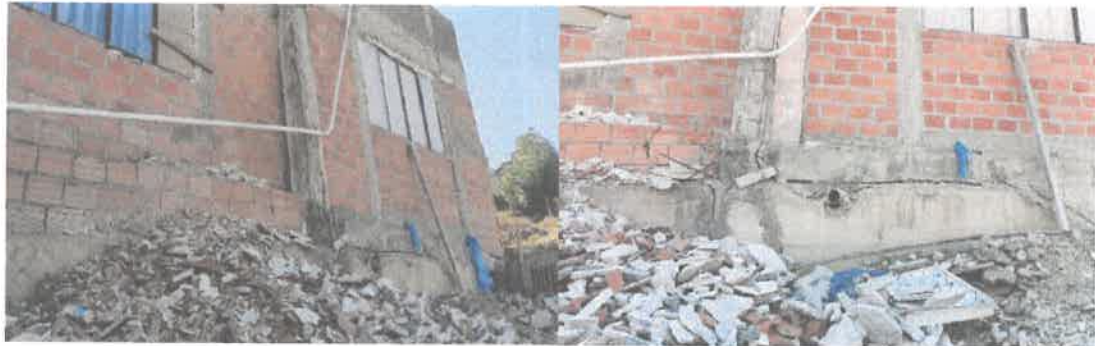
Fotografía 17. Columna de H o A afectada por el movimiento geodinámico.
