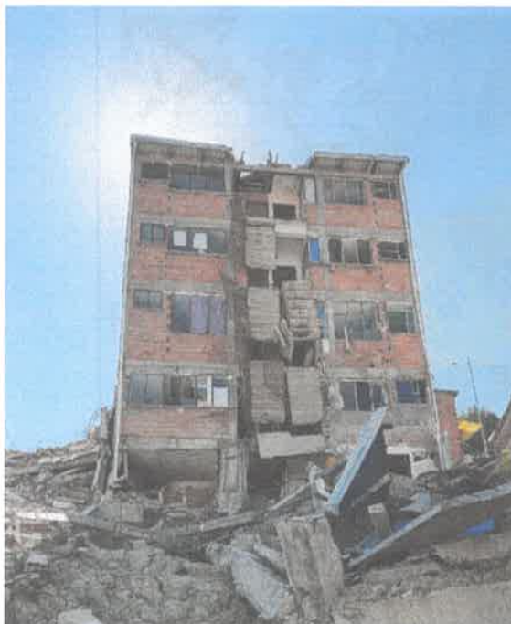
Fotografía 1. Elevación Frontal de la vivienda con el colapso parcial de las escaleras y demolición de tabiquería.
